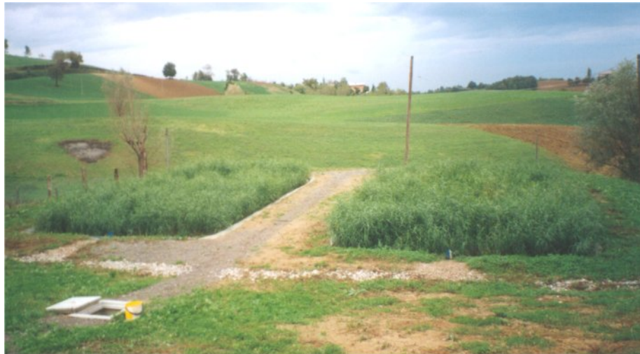
Figura 6.5: impianto di fitodepurazione su acque reflue di una sala di mungitura (Foto CRPA).
