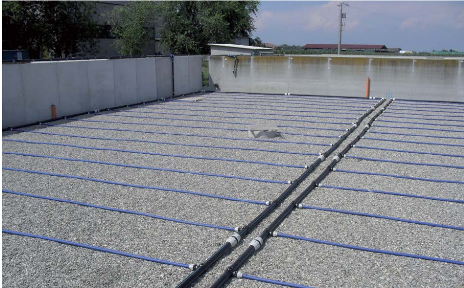
Figura 6.3: Rete delle tubazioni in un sistema SSF a flusso verticale prima dell'impianto della vegetazione (foto CRPA).
