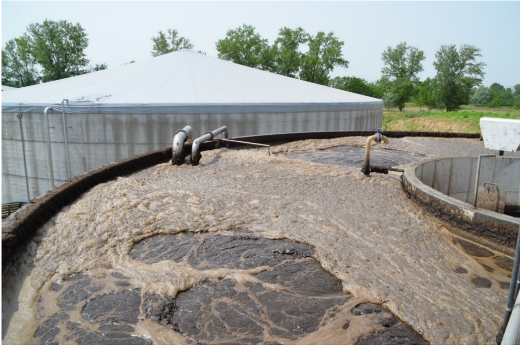
Figura 5.2: Processo di nitrificazione/denitrificazione in un'unica vasca (SBR).
