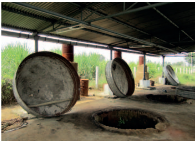
Figura 37: sezione di concentrazione del succo zuccherino presso la DCU del distretto di Medak, Andhra Pradesh (India) 148
