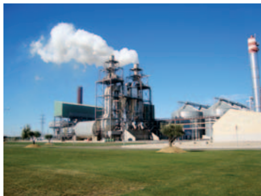
Figura 42: Impianto per la produzione di bioetanol da cereali di Abengoa Bioenergy a Babilafuente (Andalusia) 153
