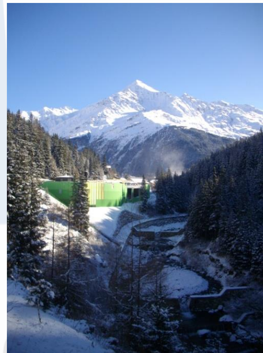
Centrale di teleriscaldamento da 12 MWt di S. Caterina Valfurva (SO)
